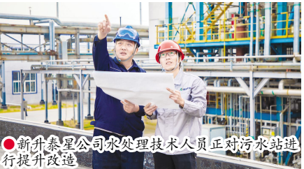
●新升泰星公司水处理技术人员正对污水站进行提升改造
