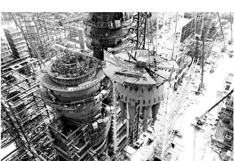
●图为催化装置安装“两器”封头依次在高空稳稳就位
