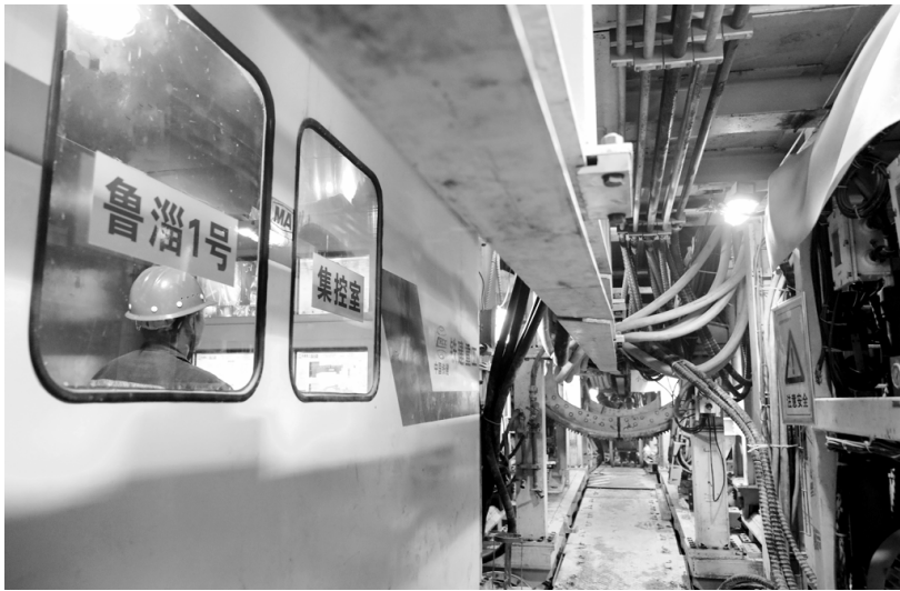
●引掘国内矿用最大直径TBM,操作人员正在操作设备进行作业。
