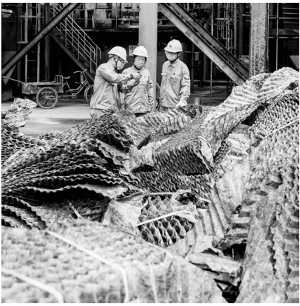
扬子热电厂新员工在检修现场接受微课堂培训。
