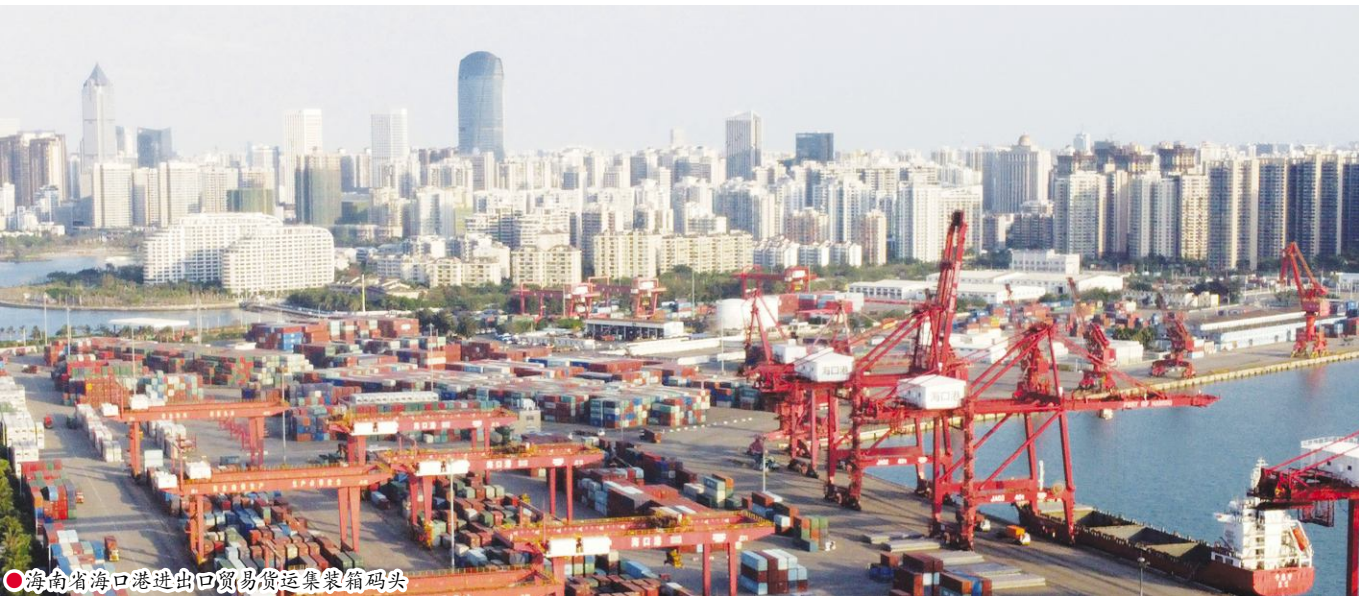
● 海南省海口港进出口贸易货运集装箱码头
