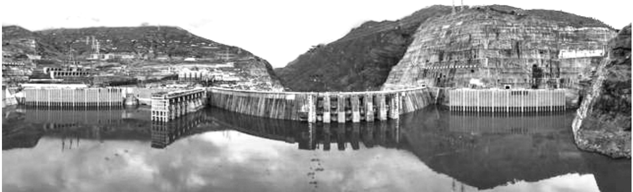
●白鹤滩水电站大坝(无人机拼接照片)。
