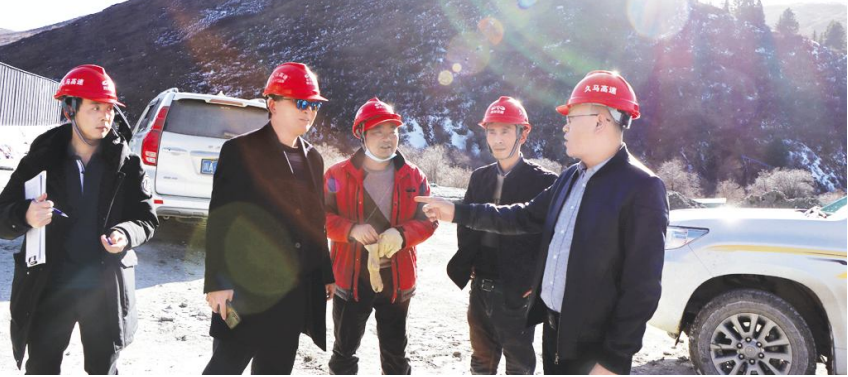
●王波在久马高速查针梁子隧道施工现场检查布置工作 (升华 摄影)
