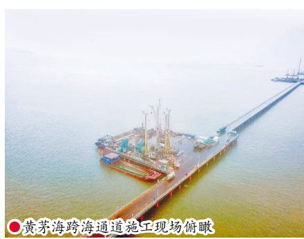
黄茅海跨海通道施工现场俯瞰
