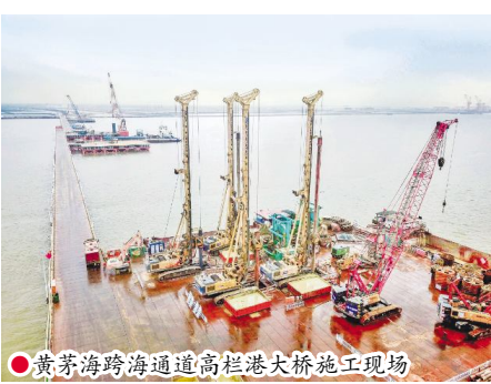
黄茅海跨海通道高栏港大桥施工现场
