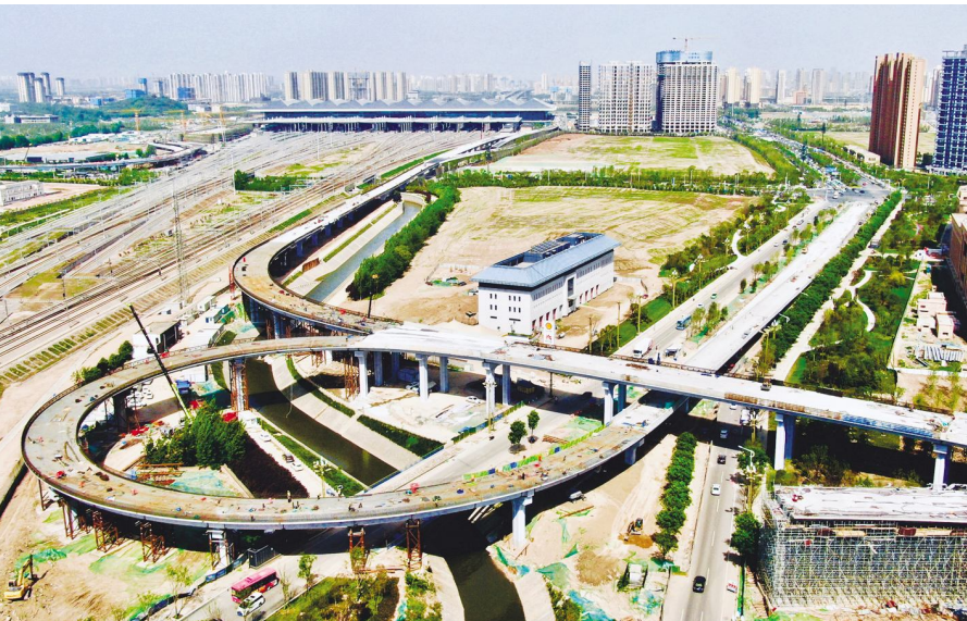
●建设中的中铁电气化局西安北客站枢纽工程(一期)高架桥工地
