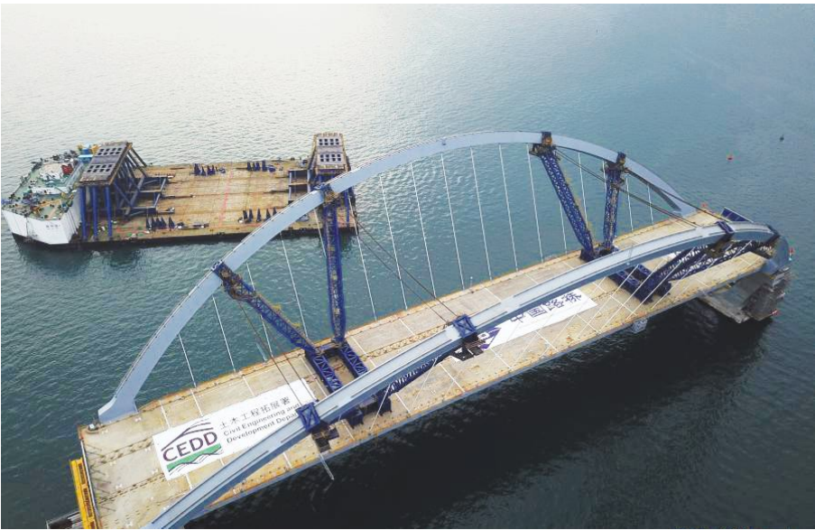
●香港将军澳大桥主桥安装成功。
