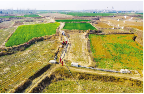
●2月22日,南阳市蓝天燃气公司在唐河县嵇岗乡铺建村民天然气管道
