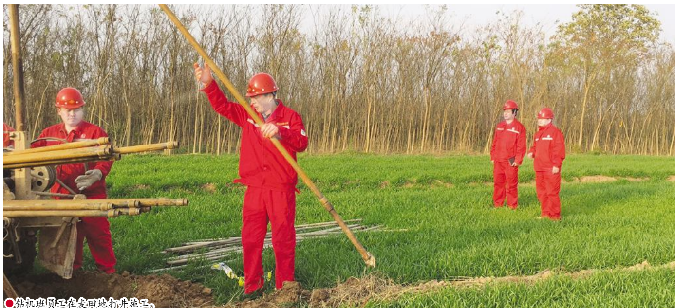
● 钻机班员工在麦田地打井施工。
