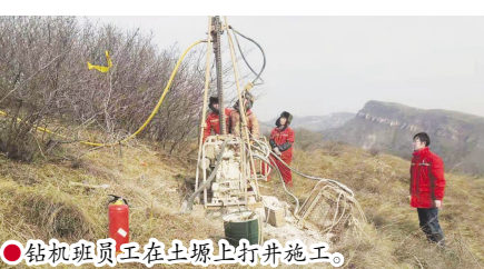
● 钻机班员工在土塬上打井施工。
