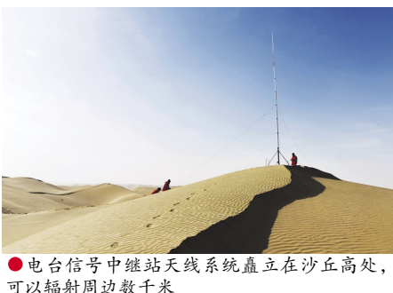
●电台信号中继站天线系统矗立在沙丘高处,可以辐射周边数千米
