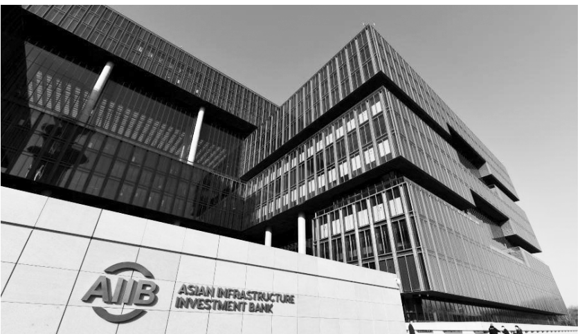
●这是位于北京市朝阳区天辰东路的亚洲基础设施投资银行总部大楼。新华社记者 李鑫 摄
