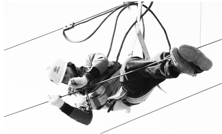
●2020年12月29日,甘肃平凉华亭市最低气温达零下15度,中国铁建电气化局三公司天平项目部员工在天华铁路华亭站改“四电”工程作业现场,顶着严寒在高空作业。
