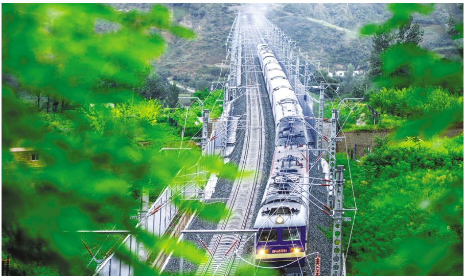
●2019 年 8 月 21 日，重载列车行驶在由中国铁建电气化局三公司建设的世界上一次建成运营最长的重载铁路——浩吉铁路卢氏境内的电气化铁路线上。
