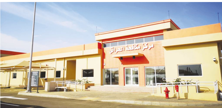
● 吉赞阿美石油应急响应中心消防站
