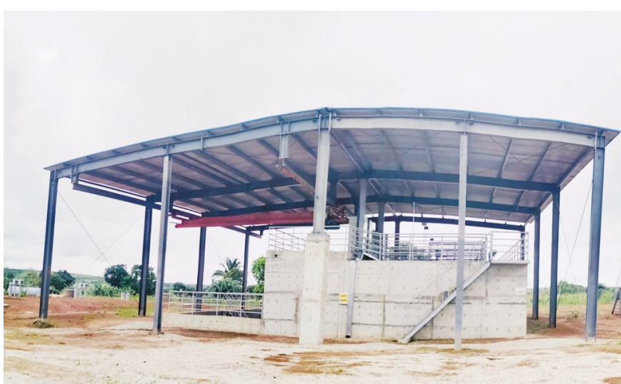
● 中铁八局海外公司承建的刚果(金)卡米娜引水和处理工程
