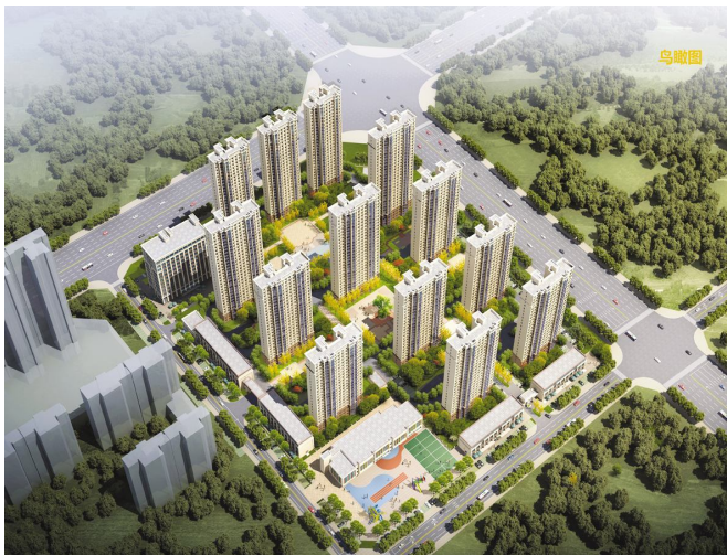
● 阜阳九里安置区装配式建筑项目
