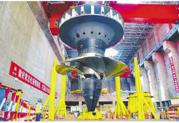
金沙水电站轴流转桨式水轮机转轮进行吊装
