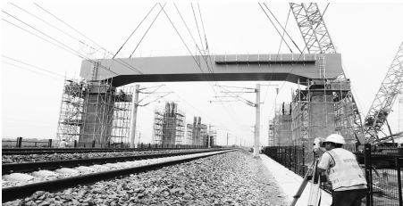
7月28日上午,中铁电气化局铁路工程公司施工的西法北城际铁路跨西银高铁钢箱梁吊装就位。
