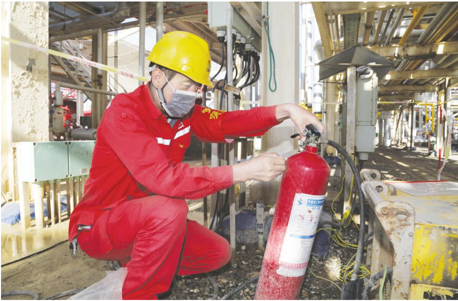
雷毅涛在检查灭火器的压力是否在安全值,软管是否有老化、裂缝现象。
