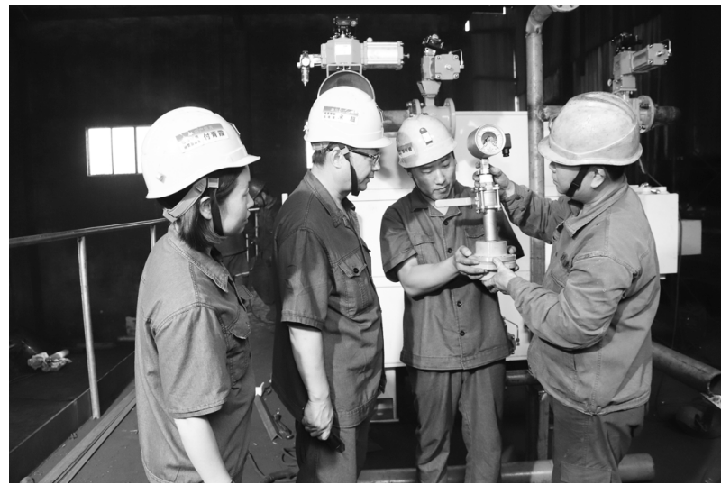
备射流式浮选机配件、单室进料空气穿流压滤机、高压风机和风机、刮板机、变压器、电缆等,为确保技术改造的顺利进行,该公司总经理宋超身先士卒,率先垂范,积极带领公司技术人员在现场,盯在现场,加班加点,夜以继日,赶工期,抓进度,保质量。目前,该公司浮选系统技术改造项目已经接近尾声,到 7 月底全部完工投入使用。
