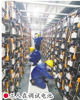
●工人在调试电池
