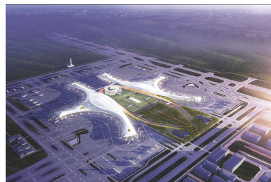
●成都天府国际机场防腐防火涂装工程
