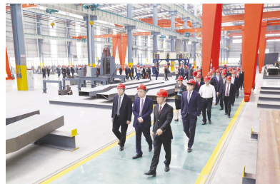
●重型钢结构生产车间
