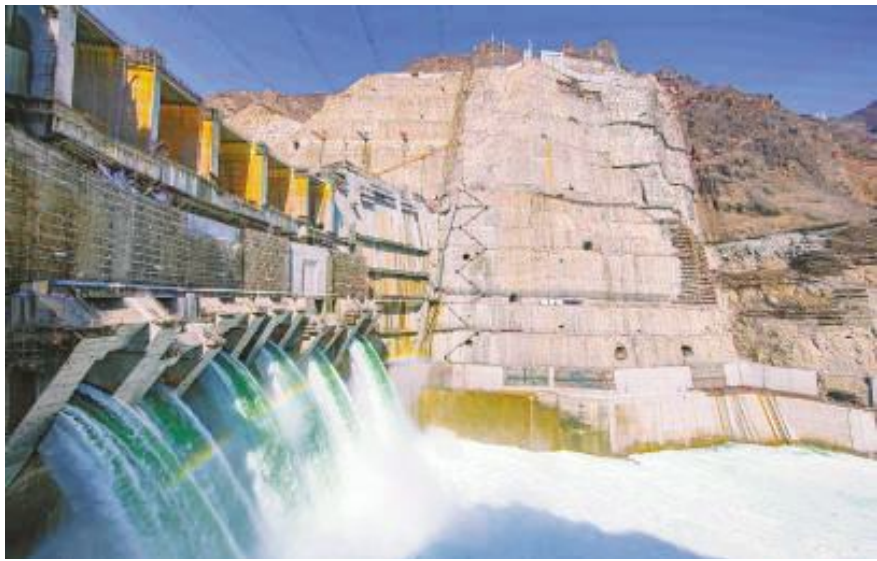
●6月29日,乌东德水电站大坝中孔过流。
