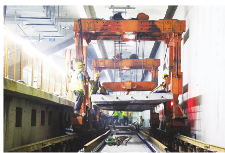
建设者在地铁隧道进行铺轨作业。(倪树斌 摄)
