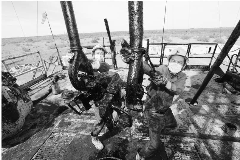
● 图为作业人员正在奋力处理故障井。
