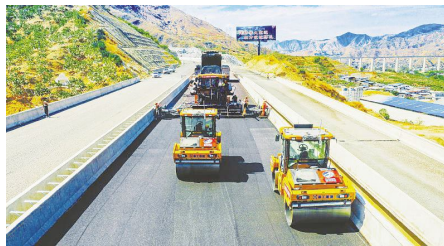
5月27日,无人驾驶压路机群联动作业在攀大高速公路仁和区路段测试成功。四川铁投供图
