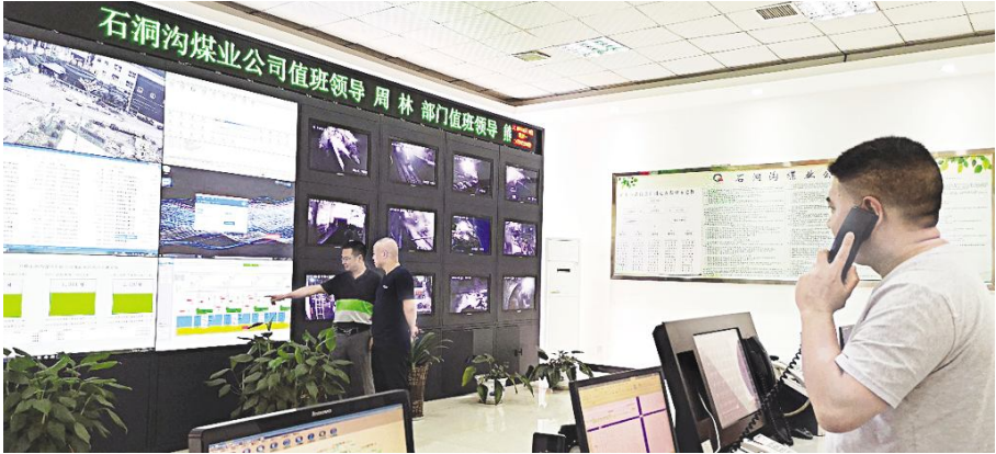
●石洞沟煤业信息化安全调度指挥中心
