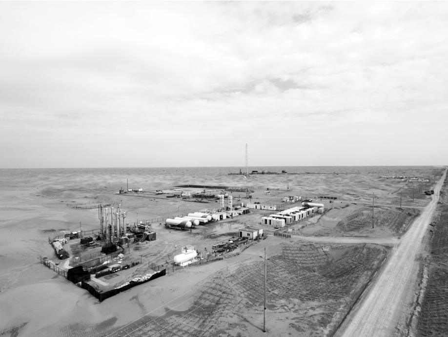
● 建设中的顺北油气田
