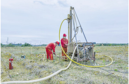
●钻井作业施工现场
