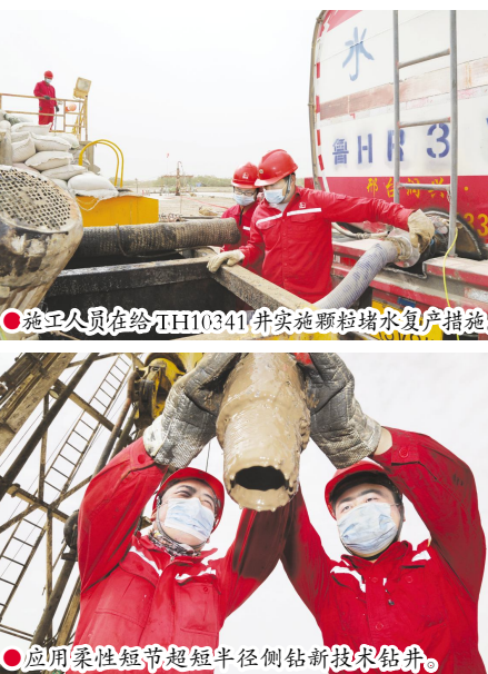
● 应用柔性短节超短半径侧钻新技术钻井。
