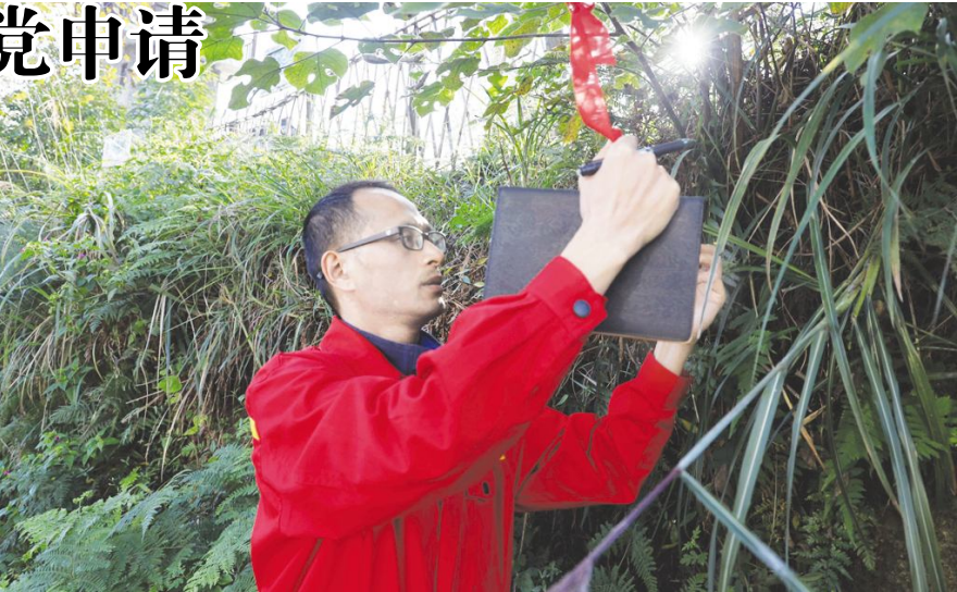
图为梁华检查测量野外施工工序质量。
