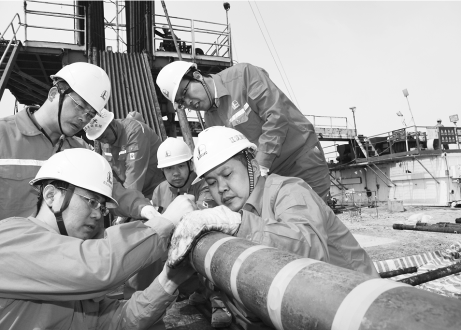
●“技术达人”邱振军(右二)在连接压裂抢施工现场。
