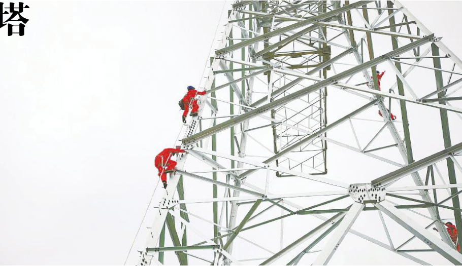
● 雅中特高压工程四川段组立第一基铁塔。 杨林 摄
