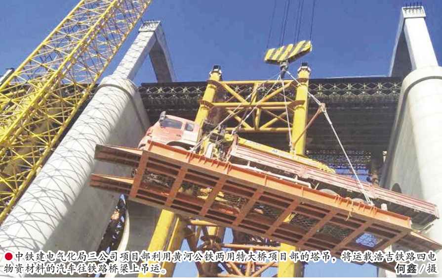
● 中铁建电气化局三公司项目部利用黄河公铁两用特大桥项目部的塔吊,将运载浩吉铁路四电物资材料的汽车在铁路桥梁上吊运。
