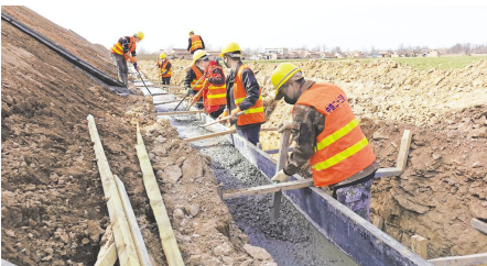
●护脚墙混凝土浇筑施工现场
