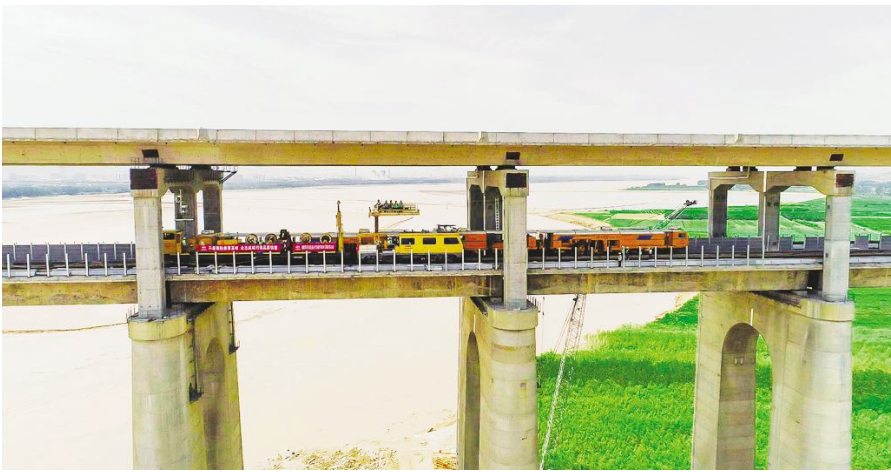
●2019年6月30日,中铁建电气化局三公司三门峡项目部员工在浩吉铁路黄河特大桥上架设最后一条接触线。
