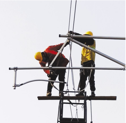
● 3 月 5 日,中铁建电气化局三公司京沈客专星火项目铁科院中心站改造项目工地上,工人在调整试车线接触网悬挂。祝首奥/摄
