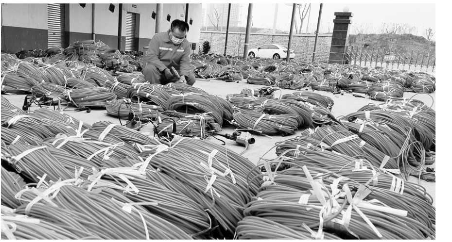
● 图为检测现场。
