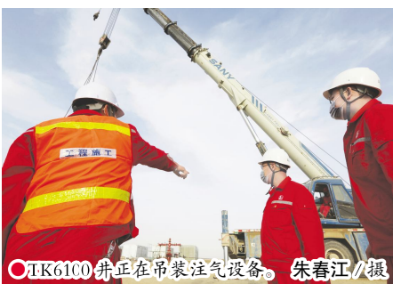
TK6100井正在吊装注气设备。朱春江/摄
