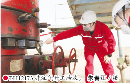
TH12173井注气开工验收。朱春江/摄
