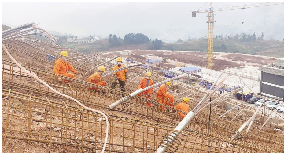
●茅台集团工程建设项目复工复产。
