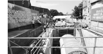
9 月 5 日,在斯里兰卡科伦坡,处于始发状态的盾构机在地下排水隧道工程现场就位。 新华社记者 唐璐 摄
