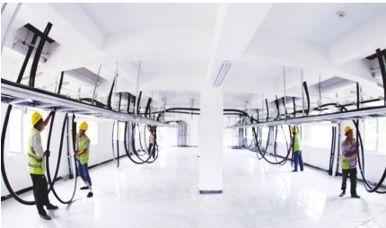
●8月5日,中铁建电气化局三公司浩吉(原蒙华)铁路(西峡)项目部工人在五里川合建所往高压配电柜引入高压电缆。(郑传海/摄)
