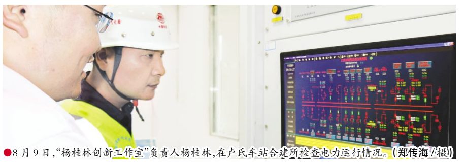
8月9日，“杨桂林创新工作室”负责人杨桂林，在卢氏车站建设所检查电力运行情况。(郑传海/摄)
