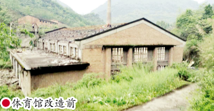
体育馆改造前
