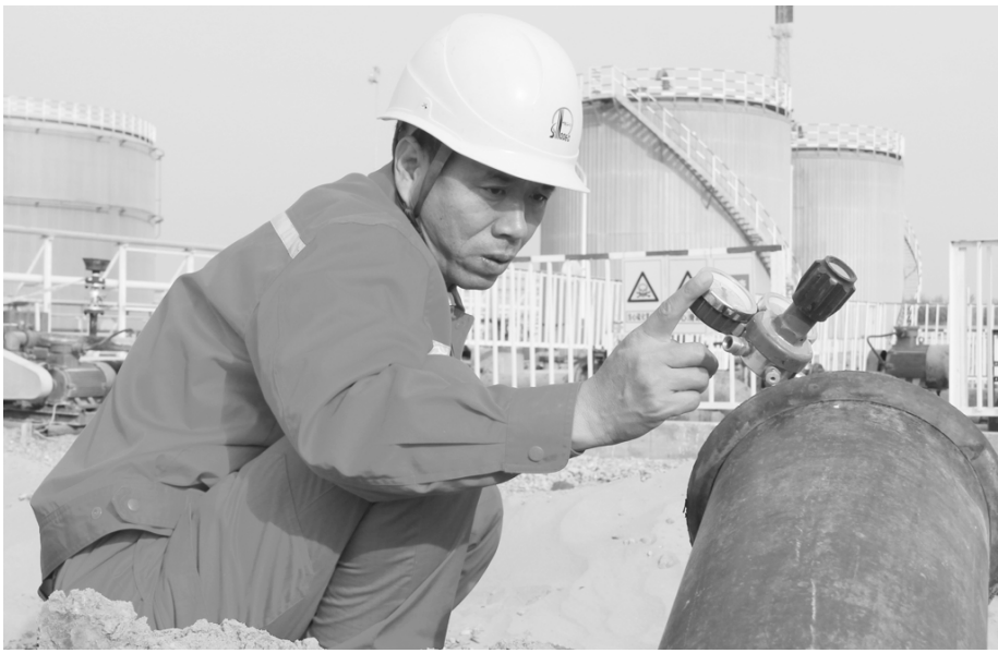
●为安全监督人员雷毅涛对施工现场使用的气瓶等仔细检查
