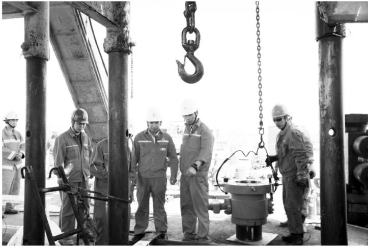
●刘玉国指导施工队更换套管接头实施注氮气三次采油。
