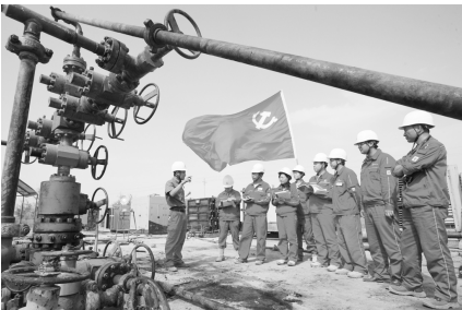
● 甲乙双方党员合力攻坚故障井。
