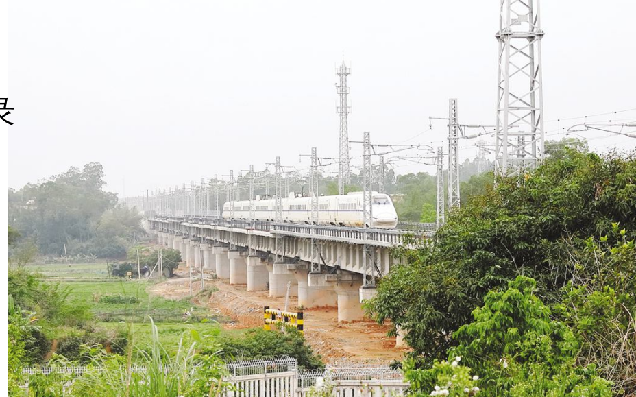
● 中铁二十三局承建的江湛铁路
